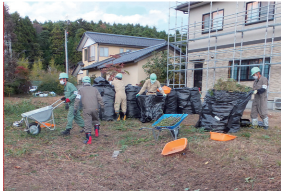
福島県内での地域除染作業
