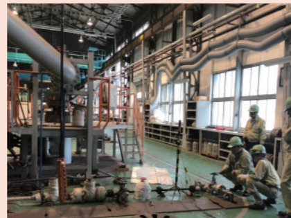
配管取付機器の性能試験
