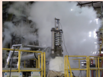
安全弁の作動漏洩試験
