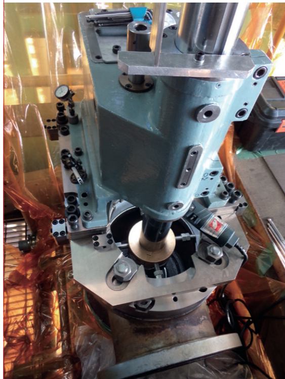
現地での弁座交換作業
