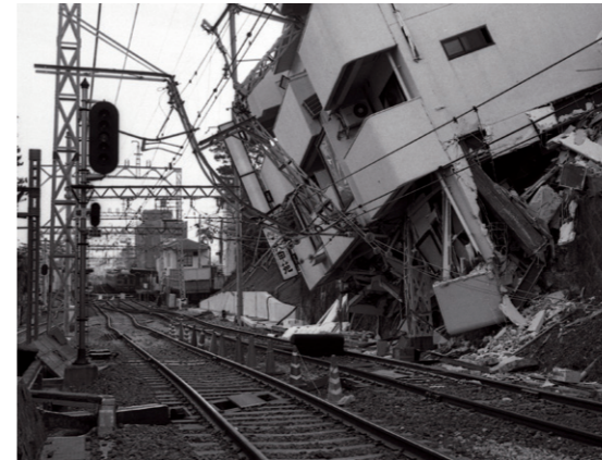
阪急夙川駅付近の被害の様子
