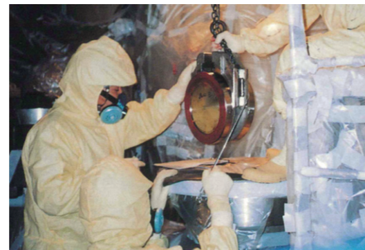
バルブ設置後のメンテナンス、点検作業
